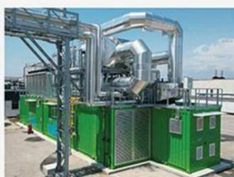
3 cogeneratori a gas naturale da 530 kW<sub>e</sub>, per la produzione di acqua e vapore, completi di sistema di gestione e controllo dei componenti termici, meccanici ed elettrici. Sistema di recupero termico per il teleriscaldamento e la produzione di energia frigorifera con assorbimento.
