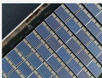
Impianto da 180 kW con pannelli fotovoltaici al silicio monocristallino ad alta efficienza sulle coperture dei Blocchi L-I. Impianti con pannelli fotovoltaici al silicio monocristallino ad alta efficienza per la realizzazione di pensiline fotovoltaiche nei parcheggi della Cittadella per 760 kW.
